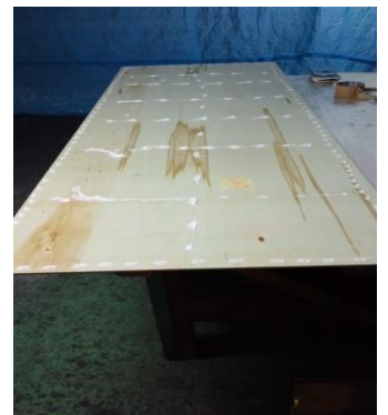
③楳抗菌パネルへの接着剤塗布 (コニシ酢ビ接着剤)
