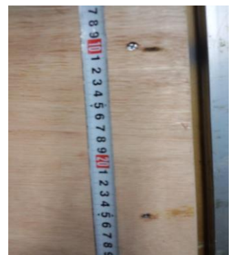
コンパネビス止め間隔 150 mm
