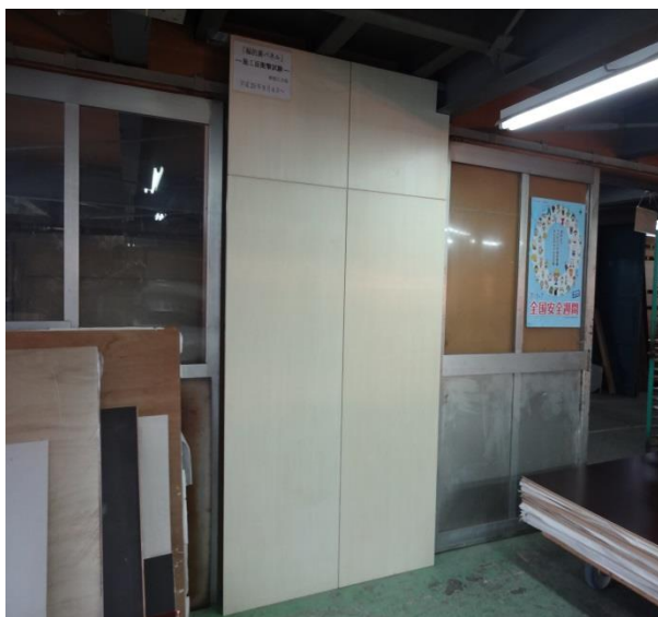
④完成施工写真
